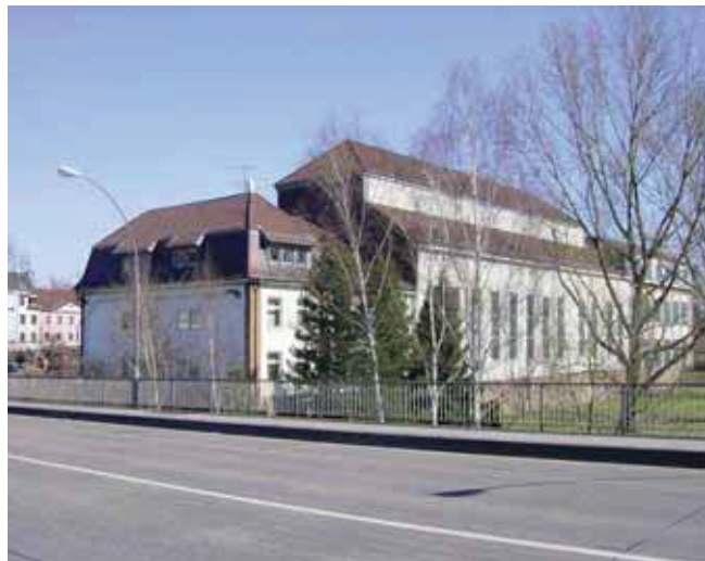
Bild 8: Gebäude und charakteristische Daten des Innovationszentrums am Standort Luisenthal mit dem Technikzentrum des IZES
