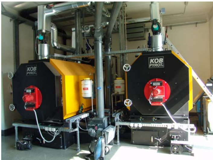
Abb. 02 Biomassekessel-Kombination (540 kW + 390 kW) (Quelle: Foto J. Bühl Ilmenau 05/ 2008)
