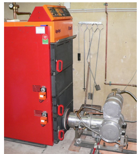
Abbildung 1: Biomassekessel mit Stirlingmotor
