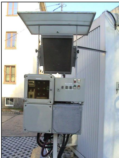
Bilder 4 und 5 Steuerungs- und Regelungstechnik der Solar-Stirling-Anlage Anlagenregelung und Kühlkreislauf (Bild 4) sowie Verbrauchersteuerung (Bild 5)
