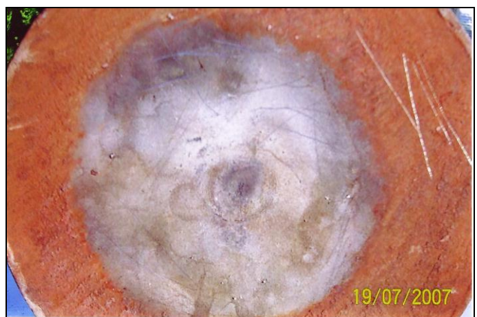
Bild 13 Verschleißerscheinungen im Absorber
