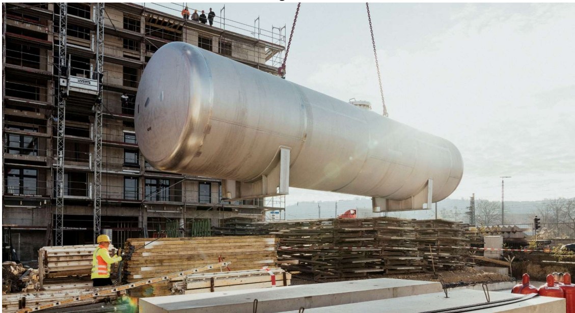
Abbildung 4: Einbringung Wasserstoffspeicher – Quelle Green Hydrogen Esslingen GmbH, Maximilian Kamps, Agentur Blumberg GmbH
